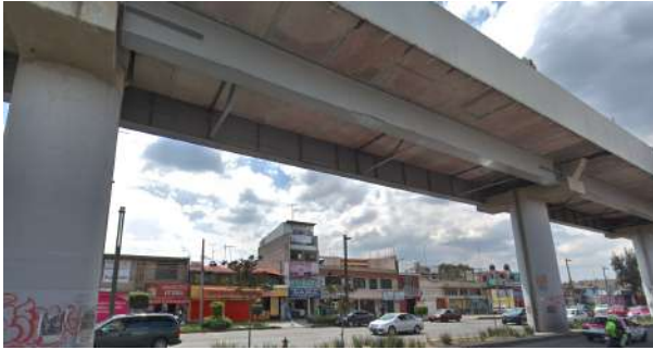
Antes de la intervención
