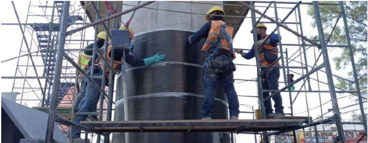
Encamisados de fibra de carbono
