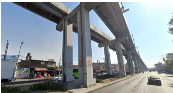
Antes de la intervención
